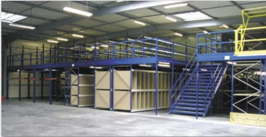
Installation multi étagée.
